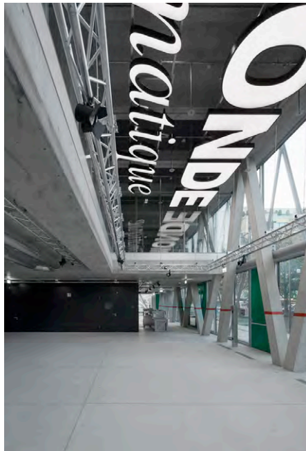
Abb. 7: Referenz Tragstruktur / doppelte Raumhöhen (taz-Bürogebäude Berlin, E2A Architekten, Zürich)
