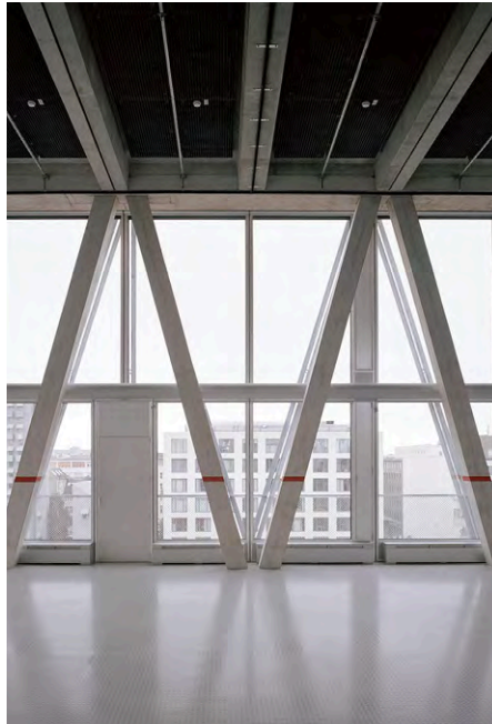
Abb. 5: Referenz expressive Tragstruktur (taz-Bürogebäude Berlin, E2A Architekten, Zürich)
