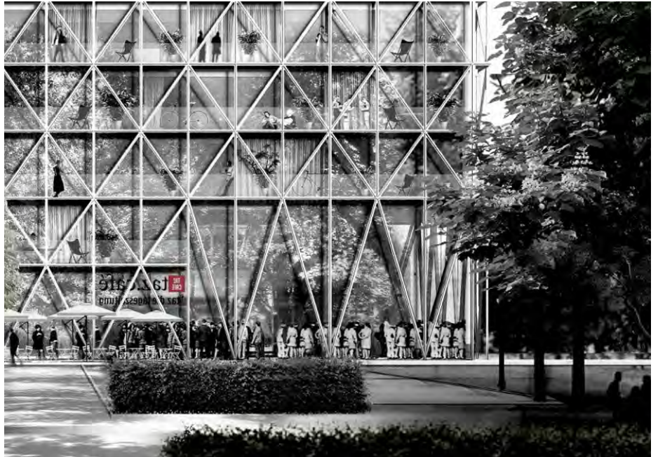
Abb. 9: Referenz Fassade/Perronhalle: Vermeidung des Eindrucks eines «schwebenden Ge- bäude» mittels umfassender Fassadenstruktur. (taz-Bürogebäude Berlin, E2A Architekten, Zürich)
